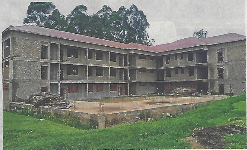
Das Bettenhaus, das der Verein „Hilfe für Kinder in Uganda“ derzeit baut, wächst zügig. Weil es teurer wird als geplant, braucht der Verein mehr Spenden. Foto: Verein
