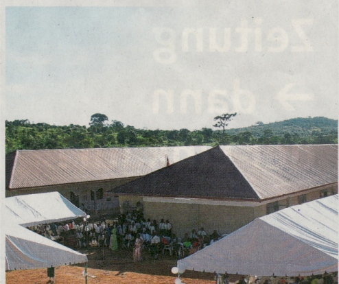
In der Nähe der Hauptstadt und doch mitten im Busch liegt Ssanda, wo die neuen Schulgebäude stehen. Wer das Dorf besuchen möchte, muss eine beschwerliche Autofahrt auf unbefestigten Pisten auf sich nehmen.
